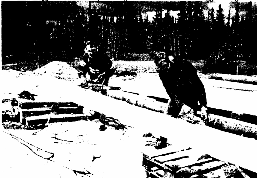
Her er laftekursets "bakgårdsgjeng", Viggo og Ingmar Eng, som holder kursdeltakerne med ferdig høvlet tømmer. Foto: Roar Lund Waade
