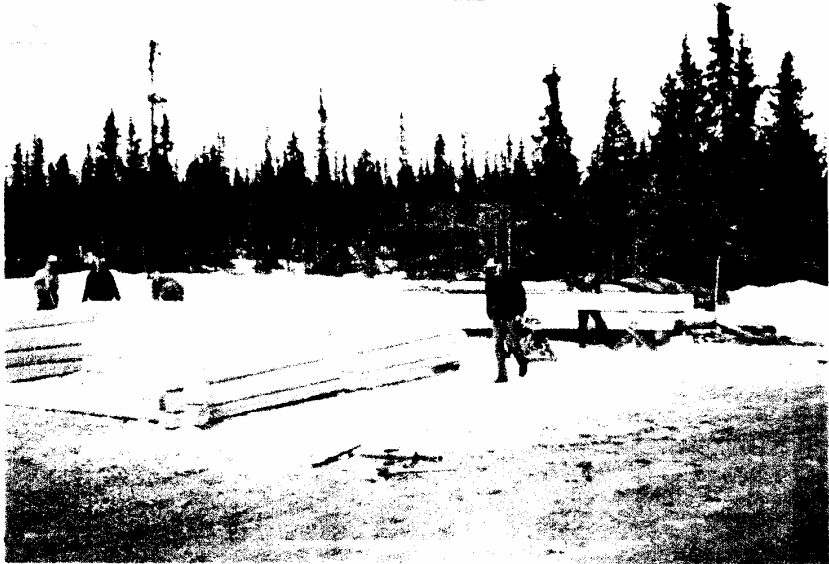
Nybyggets tredje kvarv er på plass, og laftekurset er godt i gang. Bildet er tatt mens sneen ennå ligger halvmeteren tykk i skogen. Foto: Viggo Avang
